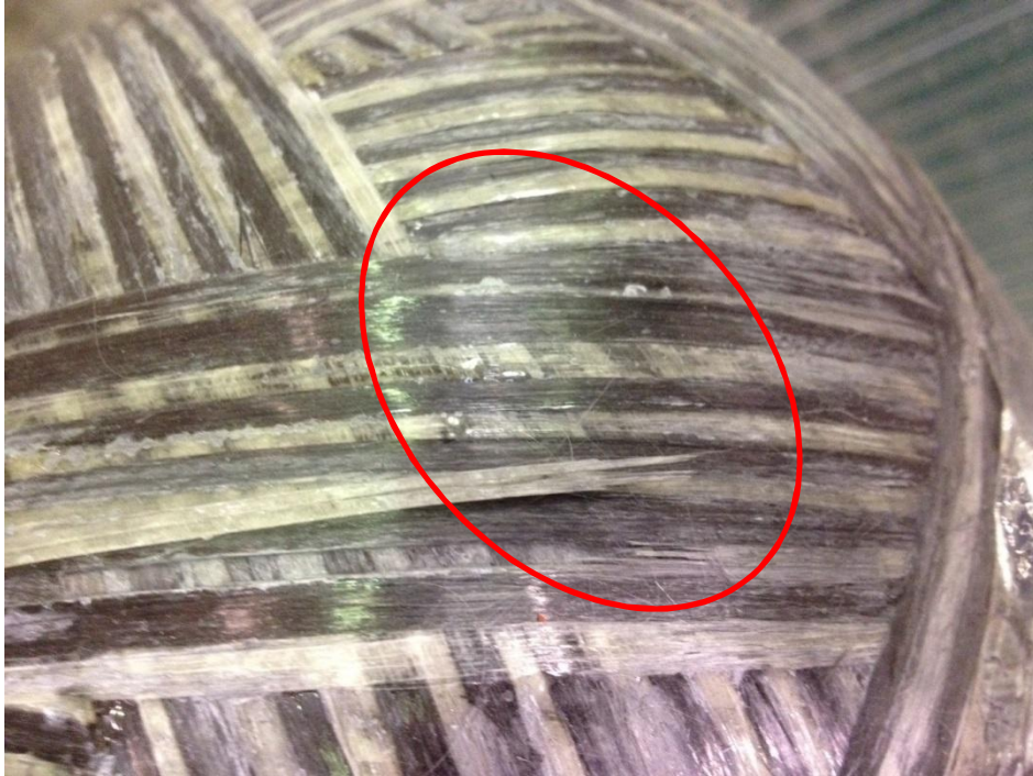
Le fasciature sono separate dalla matrice in resina.
